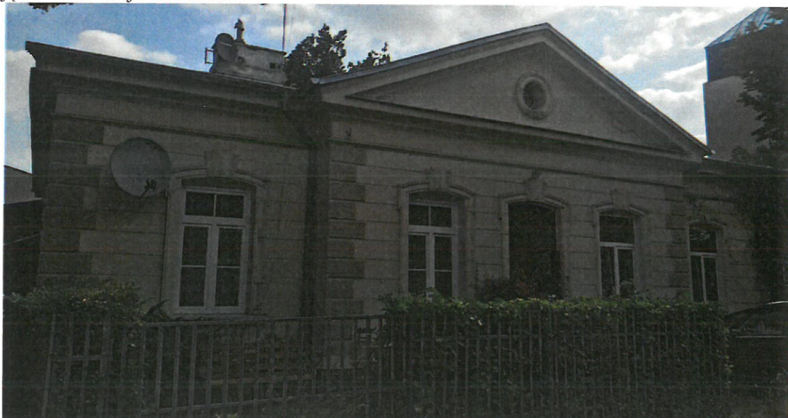
Zdjęcie – elewacja frontowa
